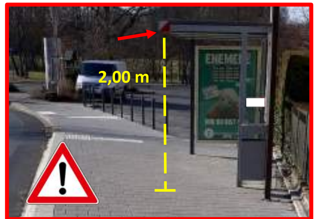
Abb. 33: Durch die Erhöhung des Bordsteins und der angrenzenden Fläche hat sich der Abstand zwischen Boden und vorderer linker Kante des Fahrgastunterstandes auf nur noch 2,00 m verringert (gelbe Linie). Auch der rot-weiße Reflektor (roter Pfeil) nutzt größeren blinden und sehbehinderten Fahrgästen nichts. Die Situation ist generell auch für größer gewachsene Fahrgäste und Fahrradfahrer gefährlich. Daher ist – wenn in Folge der Barrierefreiheit die Fläche des Unterstandes erhöht wird – zu prüfen, ob auch der Fahrgastunterstand höher gesetzt werden muss.
