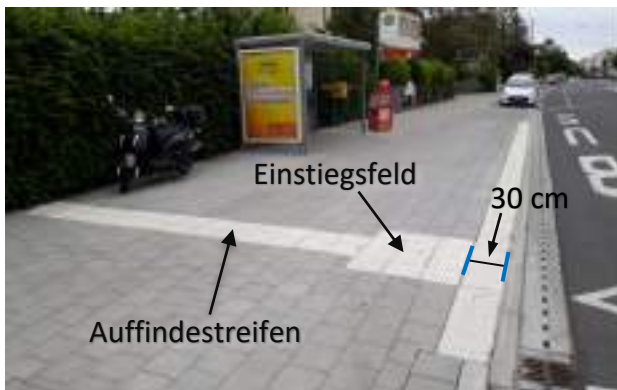
Abb. 23: Haltestelle Wiesenstraße (Steig 2), Fürth Der über die gesamte Breite des Gehwegs befindliche Auffindestreifen weist Blinde und Sehbehinderte Menschen auf die Haltestelle hin. Er hebt sich farblich von den grauen Gehwegplatten ab. Das direkt daran anschließende Einstiegsfeld markiert die Position der Tür 1 (Kontaktaufnahme zum Fahrer möglich) und befindet sich in 30 cm Entfernung von der Bordsteinkante.
